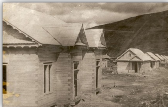
Строительство улицы «Буферная»
