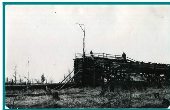
Строительство первой фабрики
